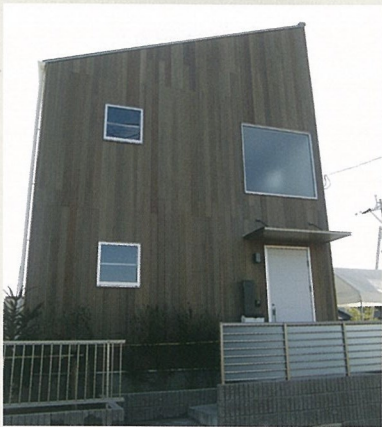
ベツダイとチャンネルオリジナル株式会社のコラボレーションによる外壁を使用したゼロキューブ。現在進行中のパッシブハウスでは、外壁に加え、木製サッシが標準仕様となり、底と開口部で温度調節する予定だ。
